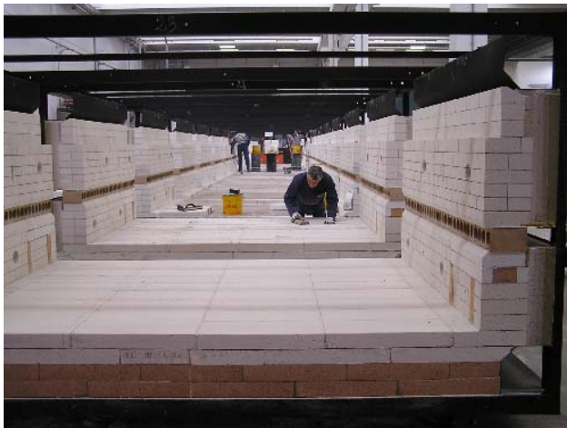
Foto 15. Costruzione forno
