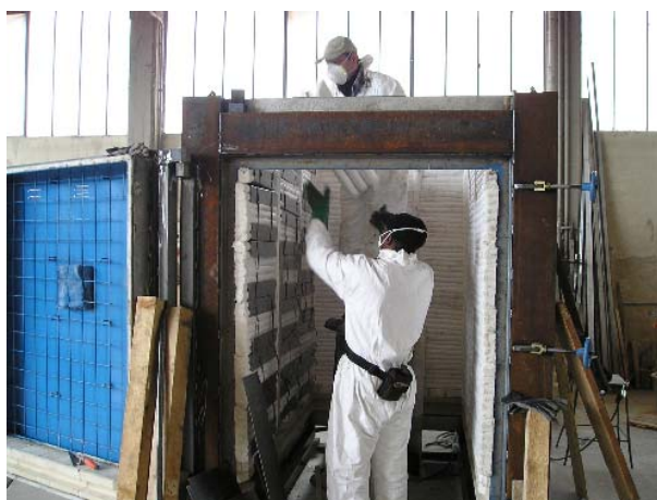
Foto 2. Montaggio moduli in FCR a coibentazione del forno
