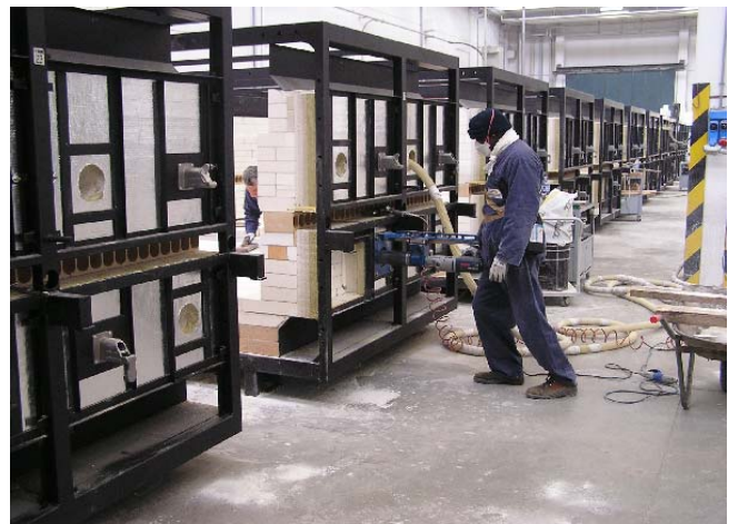
Foto 16. Fase di installazione forno
