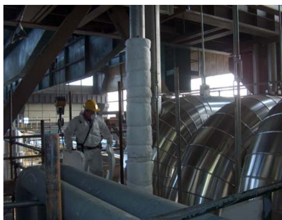
Foto 14. Coibentazione tubazione verticale e di piccolo diametro
