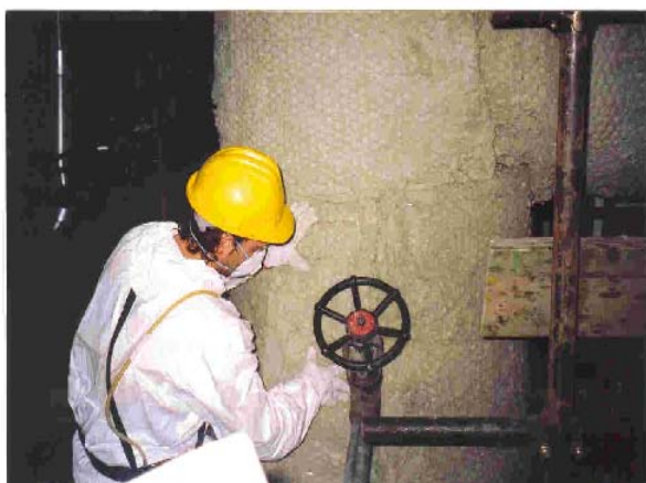
Foto 13. Operazioni di finitura coibentazione
